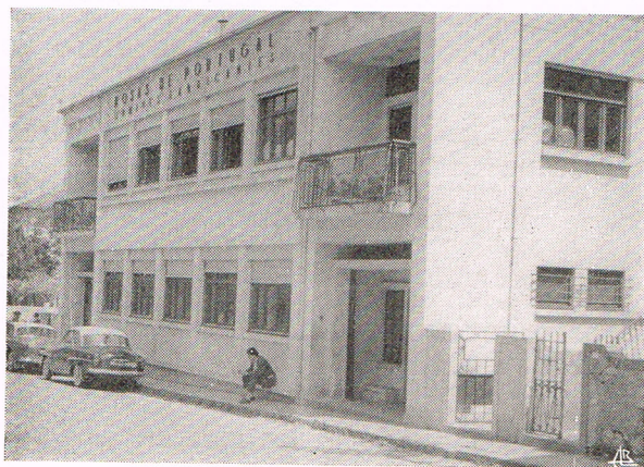
Exterior do edifício da Fábrica Rosas de Portugal
